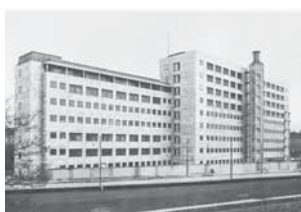
1952. Det nye telefonhus.
